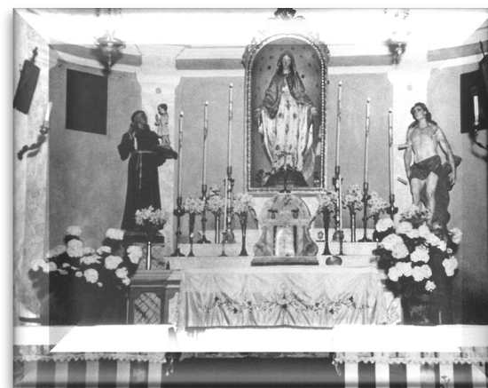
Nella foto, interno della vecchia chiesa di Colle demolita dopo il sisma del 1976
